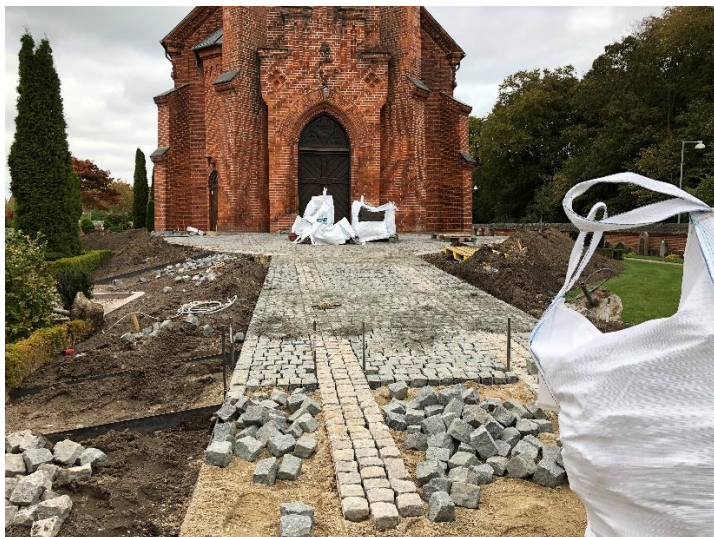
Billede: Ny brolægning under udførelse.
