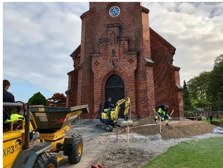
Billede: Terrænet hæves inde brolægningen begyndes.
